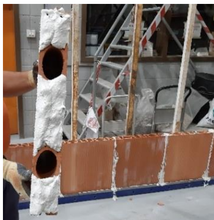
Figura 7 - Perforaciones para el paso de las instalaciones sin pasta de agarre
