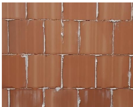
Figura 8 - Estriado de las piezas coincidentes en las hiladas
