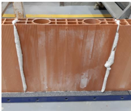
Figura 6 - Montaje de MURALIT Sin Rozas con las perforaciones en vertical
