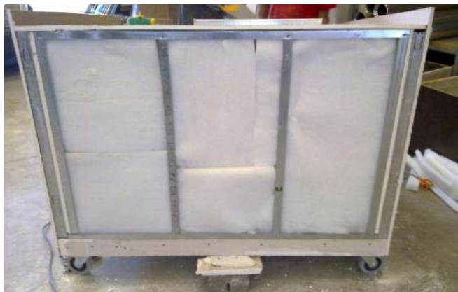
Figura 5. Detalle colocación de la lana de poliéster.
