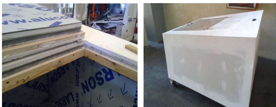
Fig. 8. Detalle compuerta y cámara terminada.
