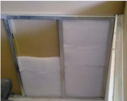
Figura 5. Detalle colocación de la lana de poliéster.
