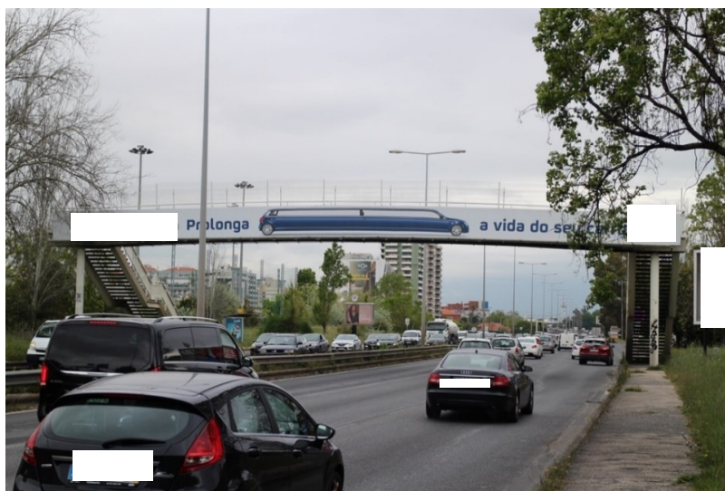
Figura 2 – Ponte pedonal utilizada na recolha de dados.
