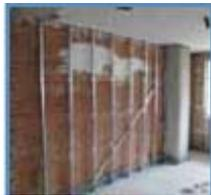
1. Se replantean los tabiques sobre el pavimento y se fijan al suelo y al techo los canales interponiendo una banda elástica en estos puntos. Los montantes que constituyen el armazón del tabique se alojan en el interior de los canales.
