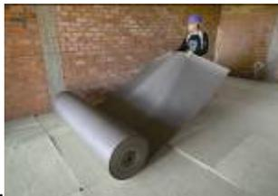
6. Para proteger los paneles aislantes de la losa de mortero, estos se cubrirán con otra lámina de polietileno
