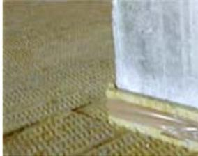
2. Para evitar transmisiones desde la parte rígida del suelo flotante hacia los encuentros con paramentos verticales, así como pilares e instalaciones que atraviesen los forjados, se debe colocar una banda perimetral de lana mineral con suficiente altura.
