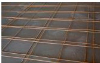
8. Se aplica una losa de hormigón de al menos 4 cm. de espesor, que puede ser armada, según los requerimientos mecánicos de la misma.
