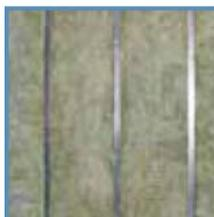
3. Se coloca el aislante de LANA MINERAL en el interior del montante desde la parte superior del tabique, es necesario que la lana rellene todo el espesor de la estructura del entramado para que el aislamiento acústico obtenido sea óptimo. La elasticidad del aislante permite el paso de las instalaciones sin producir puentes acústicos.
