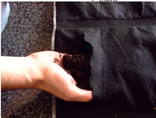
Figura 3 c) Detalle del “bolsillo” de la fachada
