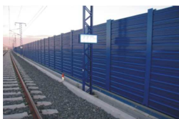
Figura 1: (a) Ejemplo de barrera acústica; (b) Efecto acústico de la interposición de una barrera entre la fuente y el receptor
