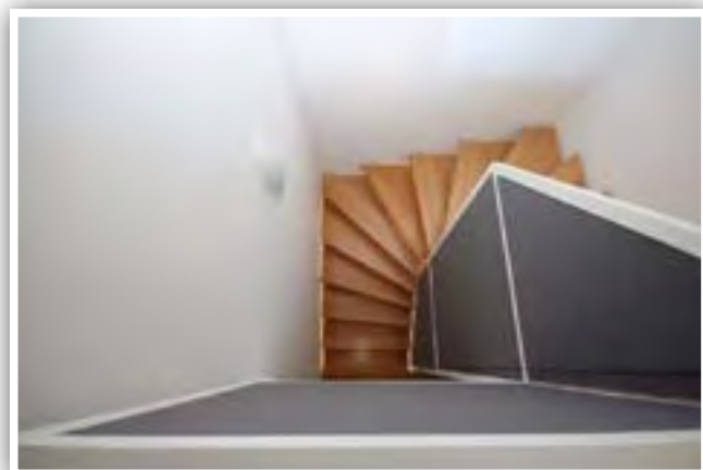
Figura 8. Vista cenital del vano de la escalera, pasamanos de acero revestido con tableros de fibra de PE.
