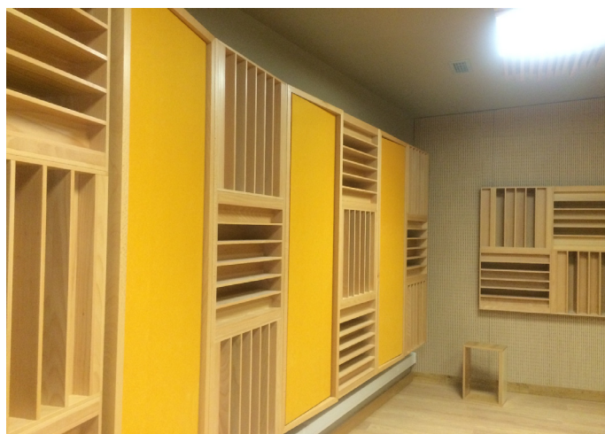
Figura 3 – Imagem ilustrativa dos painéis difusores aplicados (neste caso os do tipo QRD 7) intercalada com painéis rotativos de dupla face (posicionados com a face fonoabsorvente visível).
