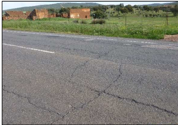
Figura 4.- Firme CM-412 deteriorado (izquierda) y espectro L_{CPTtr} de esta vía (derecha)
