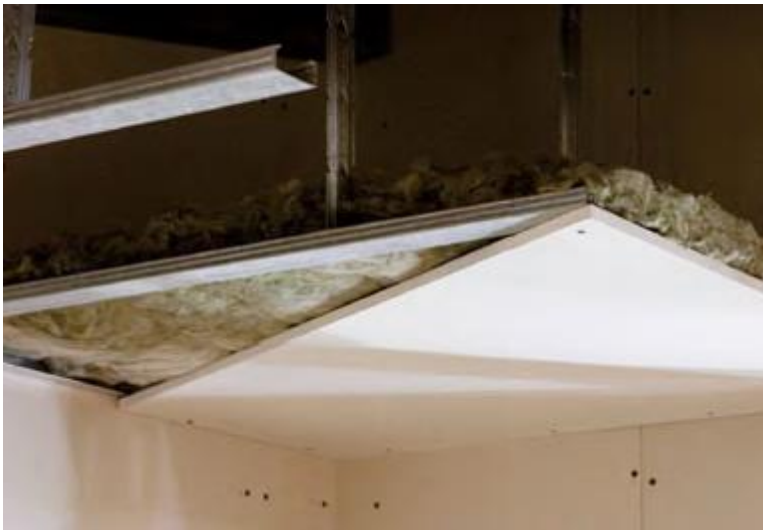
Panel URSA TERRA colocado encima de placa de yeso laminado con estructura suspendida de forjado
