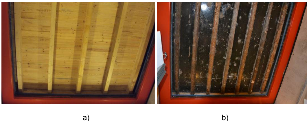
Figura 2 – Vista inferior dos provetes sem tecto-falso em situação de ensaio: a) laje de madeira; b) laje LOGCork.
