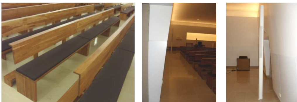
Figuras 6, 7 e 8 – Pormenor dos bancos almofadados (à esquerda), da inclinação da parede para minimizar as reflexões múltiplas (ao centro) e altifalante da marca Bose (à direita).
