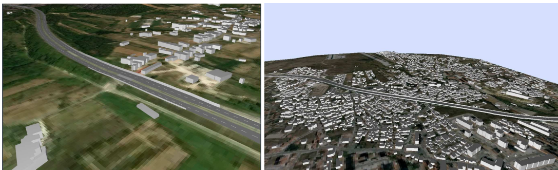
Figura 3 – Exemplo de uma medida de redução de ruído: barreiras acústicas na A1 para proteger uma pequena quantidade de edifícios habitacionais perto de Condeixa (esquerda); barreiras acústicas extensas para proteger uma área urbana densa na A5 (direita).
