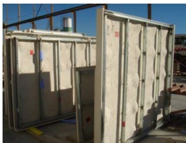
Figura 1. Lámina de GRC y sistema de fachada analizado
