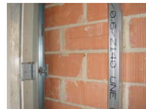
Figura 2. Detalle de los encuentros en obra fachada-forjado y fachada-pared. Promoción de viviendas ubicada en Hospitalet.
