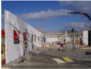
Figura 3. Panel prefabricado de hormigón macizo
