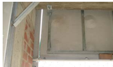
Figura 2. Detalle de los encuentros en obra fachada-forjado y fachada-pared. Promoción de viviendas ubicada en Hospitalet.
