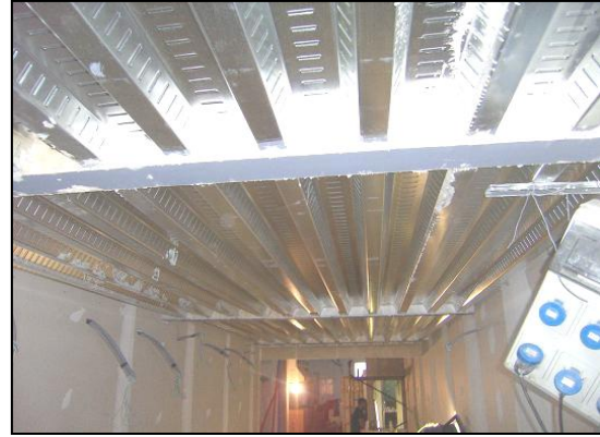
Figura 8. Losa finalizada, a falta de colocar el acabado inferior
