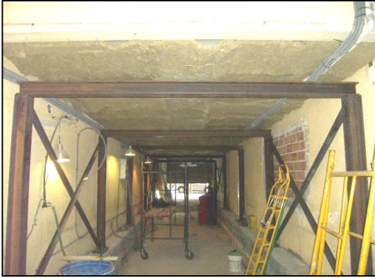
Figura 7. Estructura en construcción. Ver lana de roca sujeta al techo
