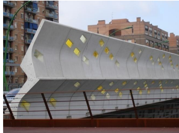
Pantalla acústica (Miralles – Arau) en Gran Via de les Corts Catalanes (Barcelona). (Fotografías del autor).
