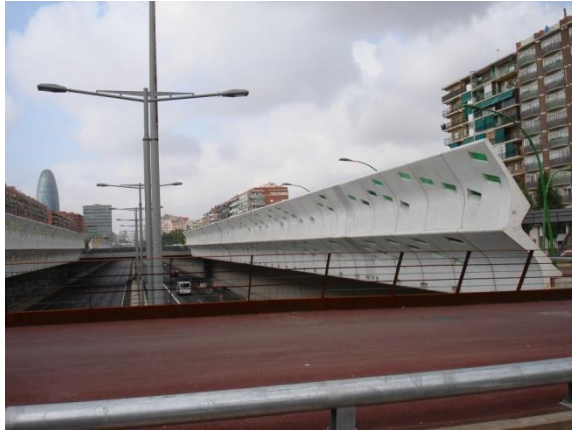
Pantalla acústica (Miralles – Arau) en Gran Via de les Corts Catalanes (Barcelona). (Fotografías del autor).
