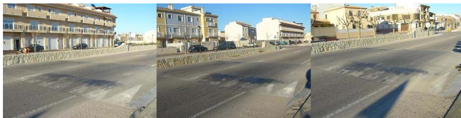
Badenes de hormigón
