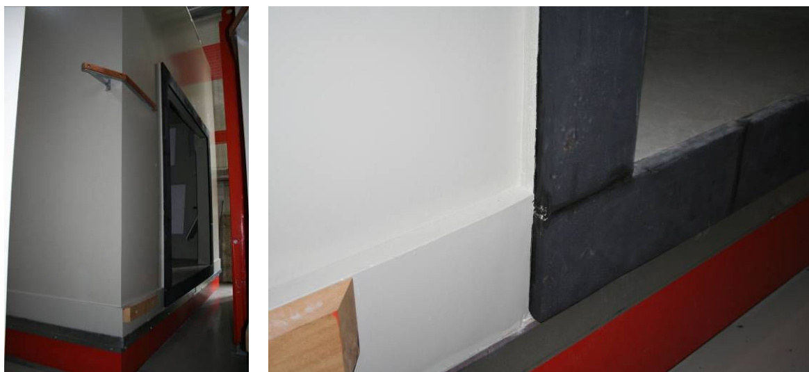
Figura 7 – Zona onde se insere o aro do provete de ensaio na câmara horizontal móvel: a) aspecto geral; b) pormenor das bandas de isolamento para encosto dos aros.
