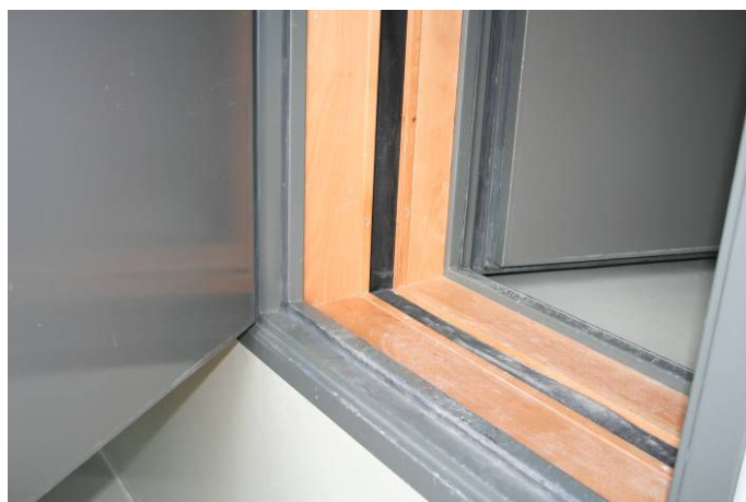
Figura 3 – pormenor das portas de acesso ao interior da câmara fixa.
