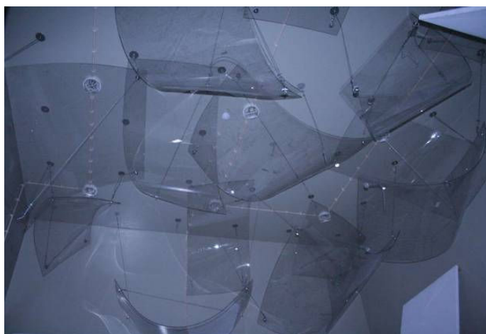
Figura 2 – Difusores fixos, constituídos por painéis em polycarbonato, dispostos no tecto da câmara horizontal fixa.
