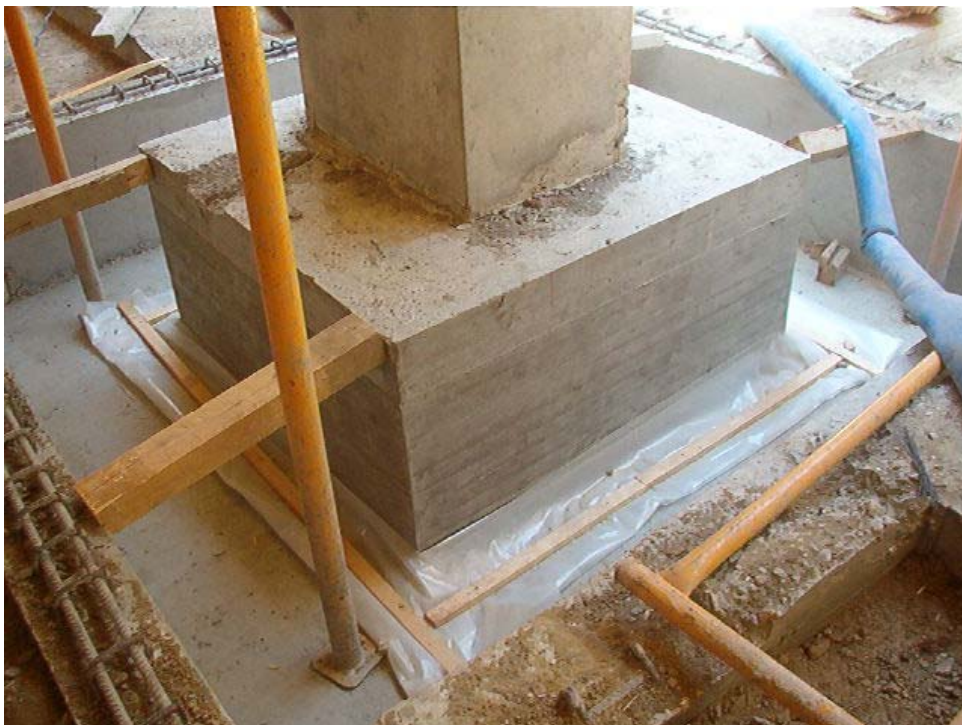
Figura 6 – Pilar assente sobre apoios resilientes
