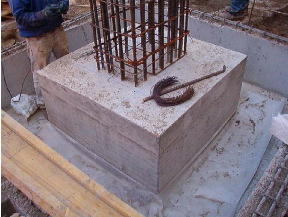
Figura 5 – Base de pilar
