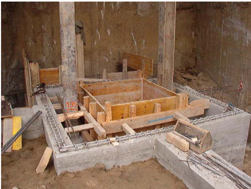
Figura 4 – Cofragem de base de pilar
