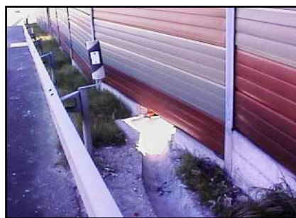
Figura 10 – Valeta à superfície
