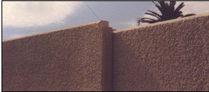
Figura 6 – Painéis de Betão Armado com acabamento tipo pedra bujardada beje
