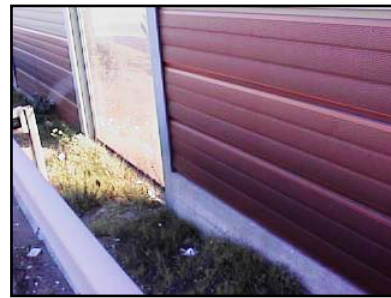
Figura 9 – Painel a apoiar no solo, sem lintel
