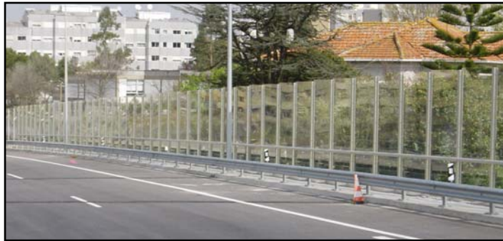
Figura 7 – Painéis em acrílico extrudido incolor
