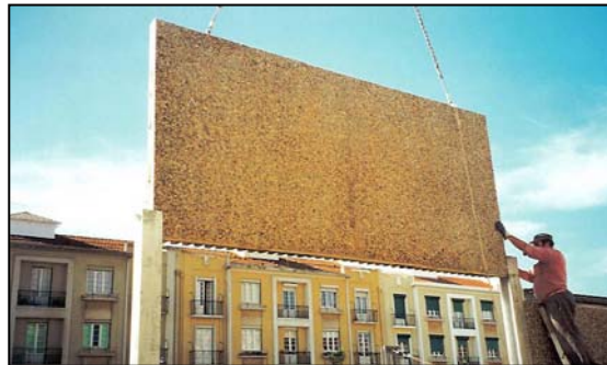
Figura 5 – Painel de Betão Madeira com acabamento em godo lavado
