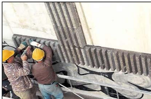
Figura 3 – Placas de Betão Madeira BBS aplicadas directamente sobre muro
