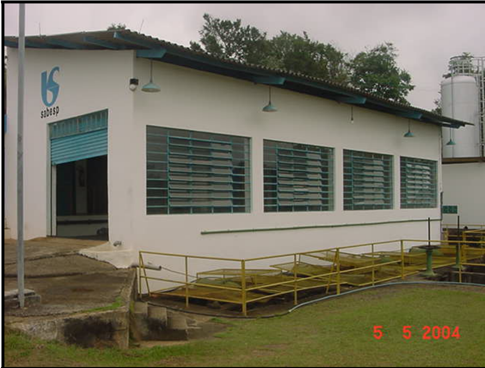
Figura 2: Captação e Estação Elevatória de Água Bruta – Taubaté
