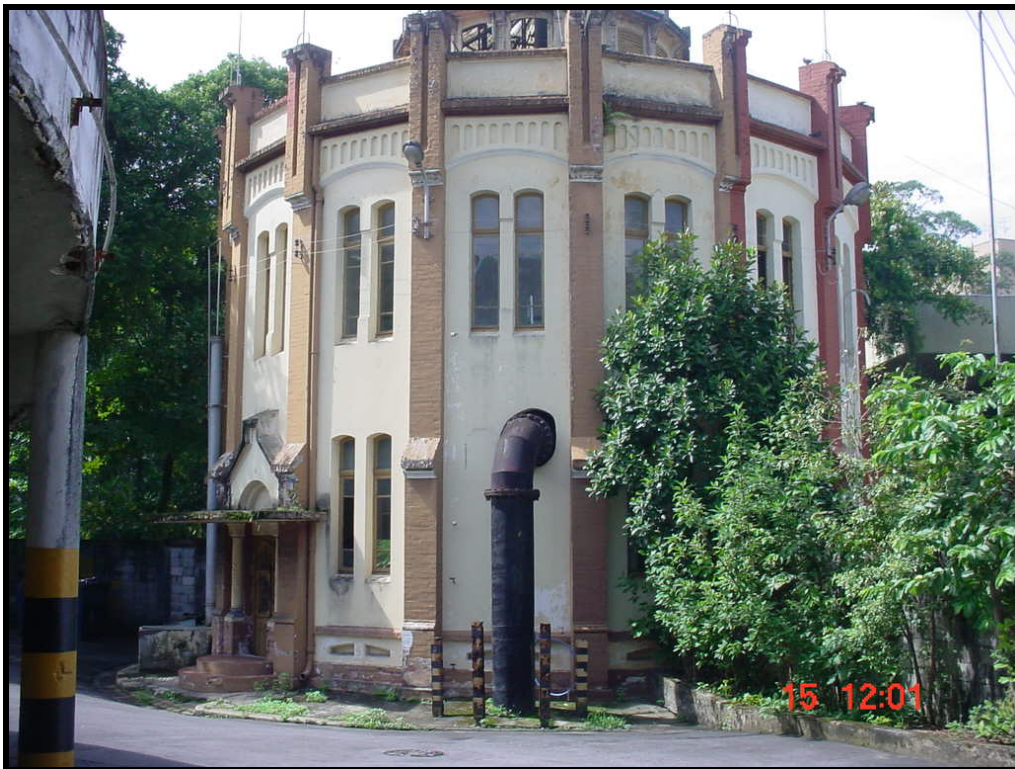
Figura 1: Estação Elevatória de Esgoto Rebouças - Santos
