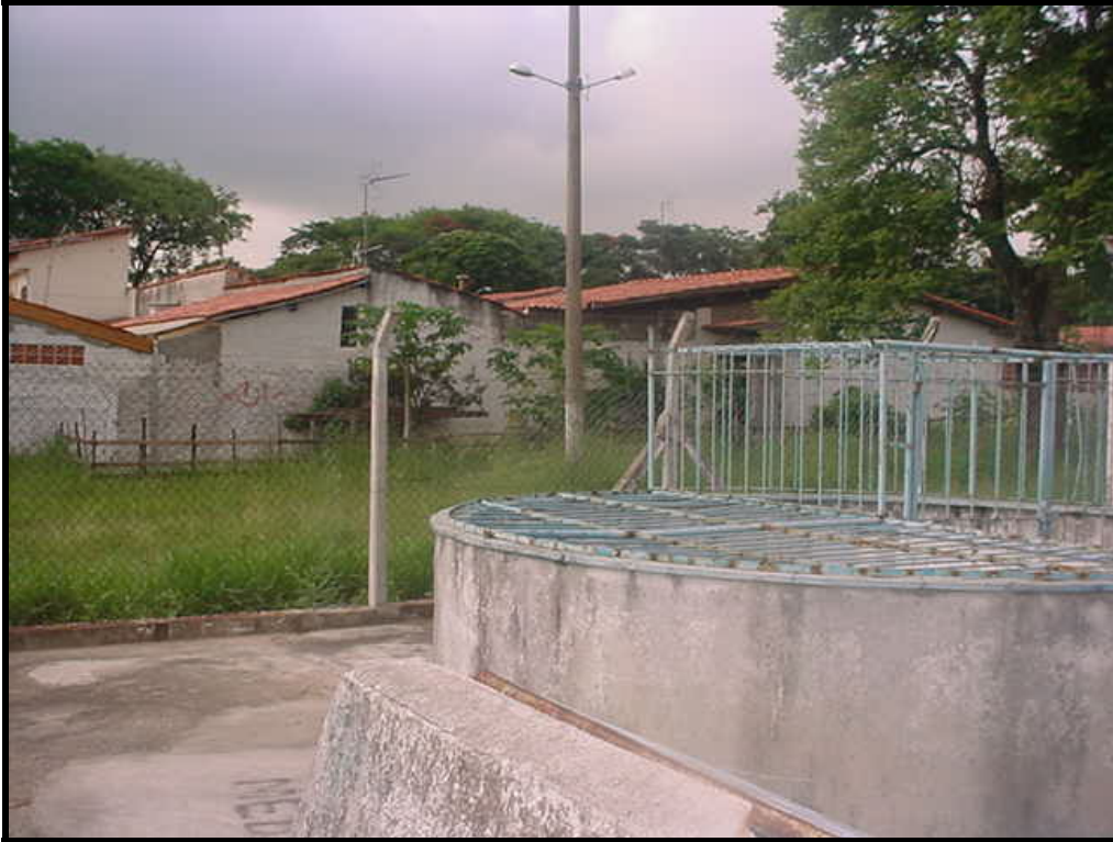
Figura 5: Estação Elevatória do Vista Verde – Detalhe do Acesso
