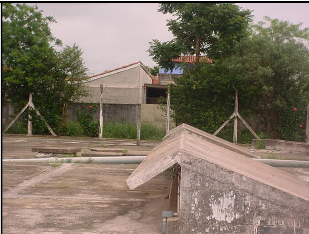
Figura 6: Estação Elevatória do Vista Verde – Detalhe Abertura de Ventilação
