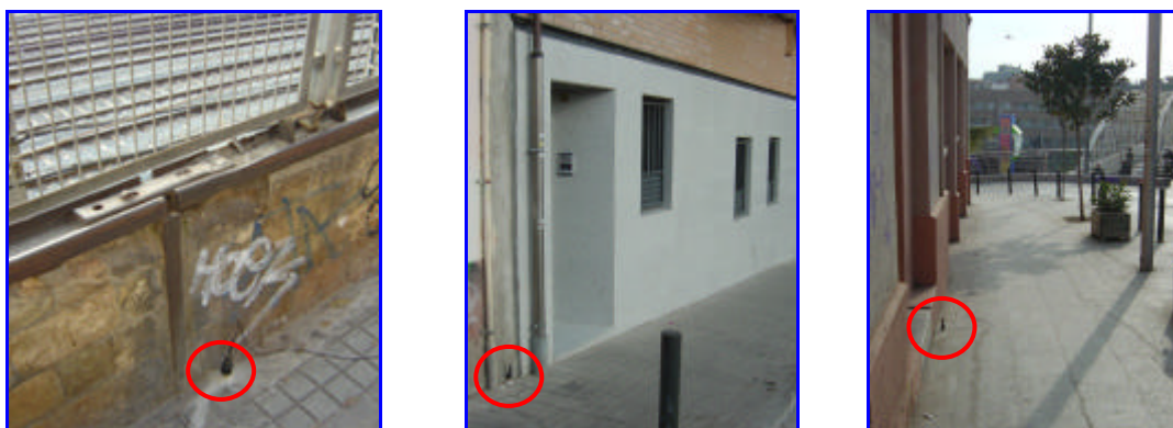
Figura 4: Ejemplo de fijación de algunos acelerómetros sísmicos en uno de los receptores
